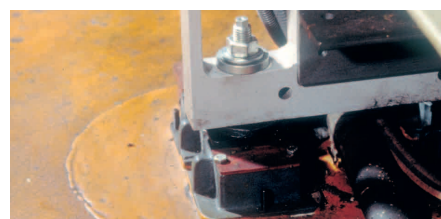
4 Fijación de equipo mecánico.
