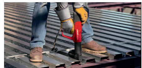
7 Sujeción de cubierta a estructura metálica mediante clavos y pernos accionadas por pólvora y tornillos.
