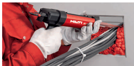
9 Protección cortafuego en penetraciones, tuberías y juntas.
